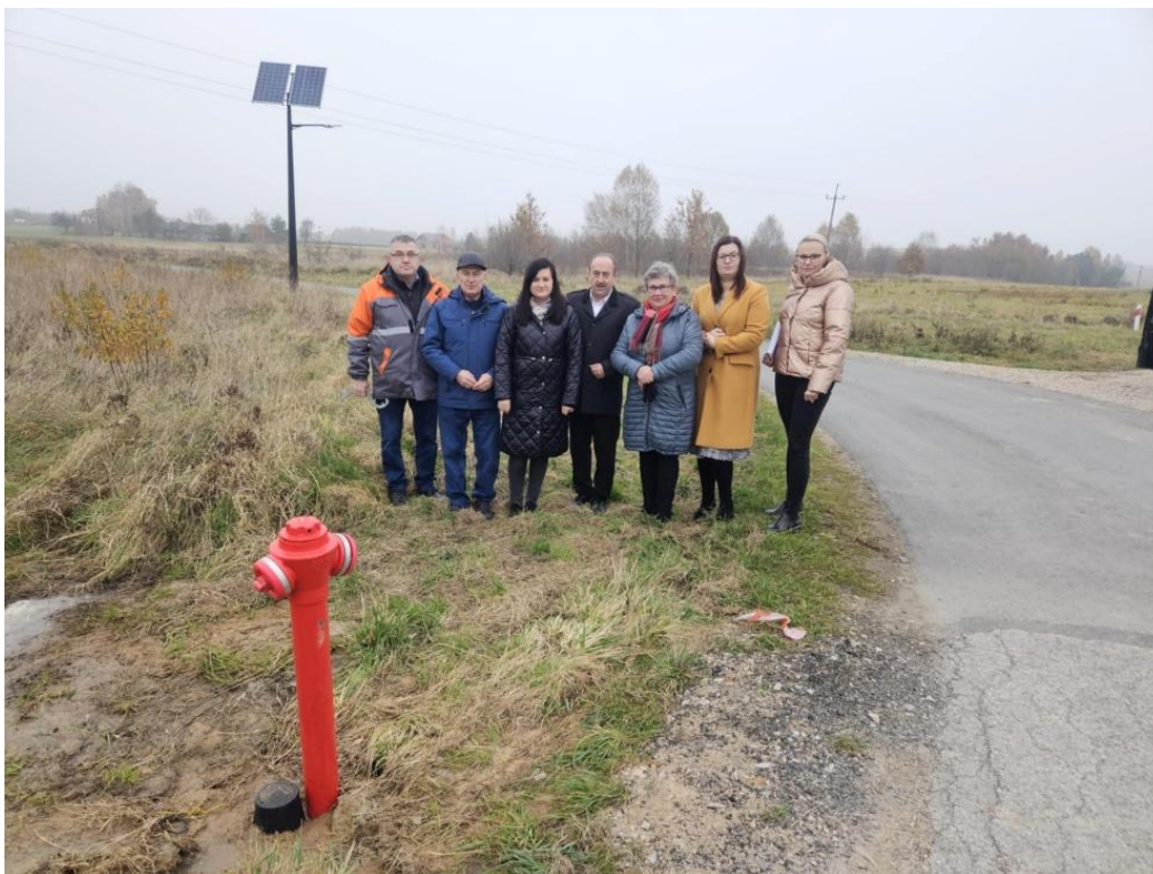
Zdjęcie z odbioru sieci wodociągowej w Łopusznie
