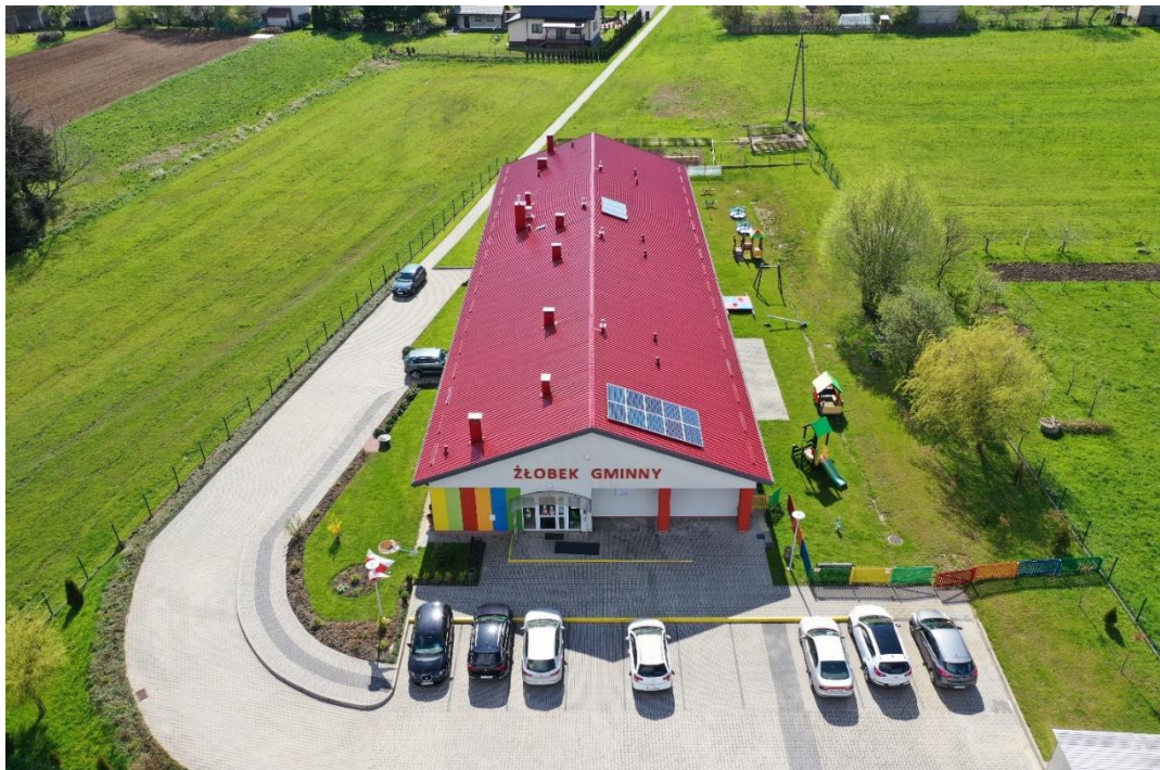
Budynek Miejsko – Gminnego Żłobka w Łopusznie
