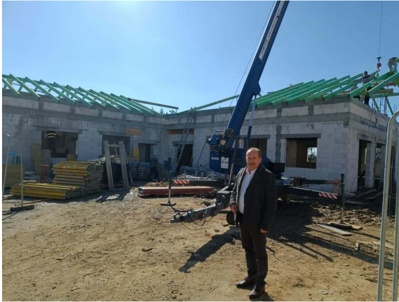
Plac budowy w Łopusznie
