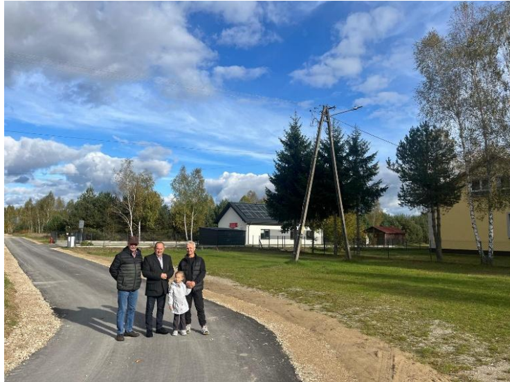
Remont drogi wewnętrznej w miejscowości Fanisławice
