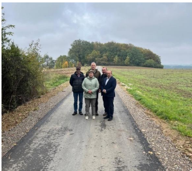
Przebudowa drogi wewnętrznej w Lasocinie
