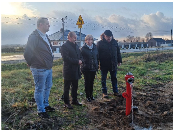
Inwestycja wodociągowa w miejscowości Piotrowiec
